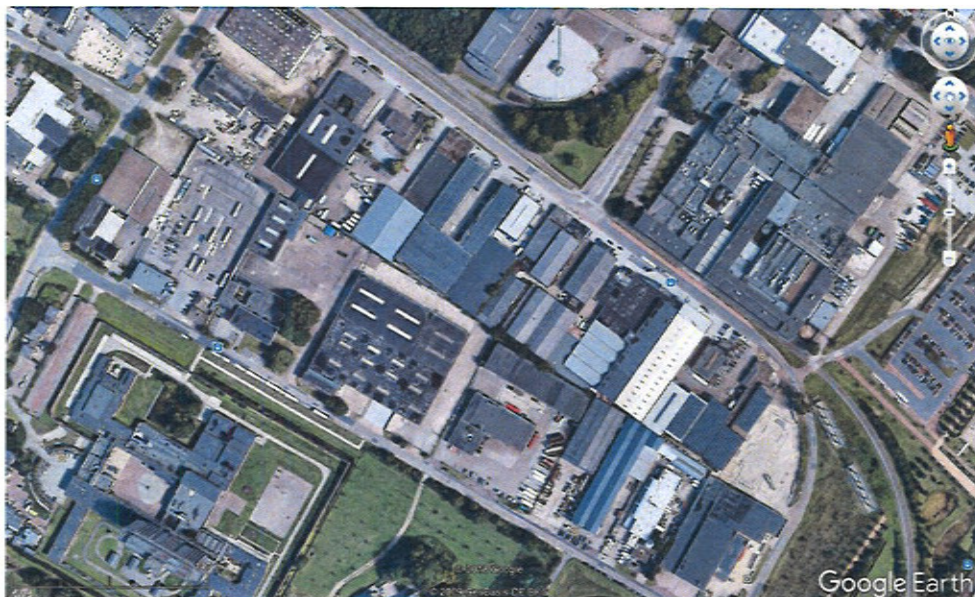
Gebied Karveelweg oost 13 daken totaal oppervlakte 33.200m 2
